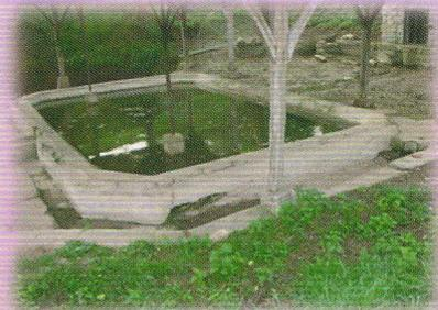
Le réservoir de la fontaine a été vidé de sa boue, les restes de l'abreuvoir de gauche sont apparus, le pavage et la rigole d'écoulement en pierres sont en cours de dégagement. Mais beaucoup reste encore à faire...
